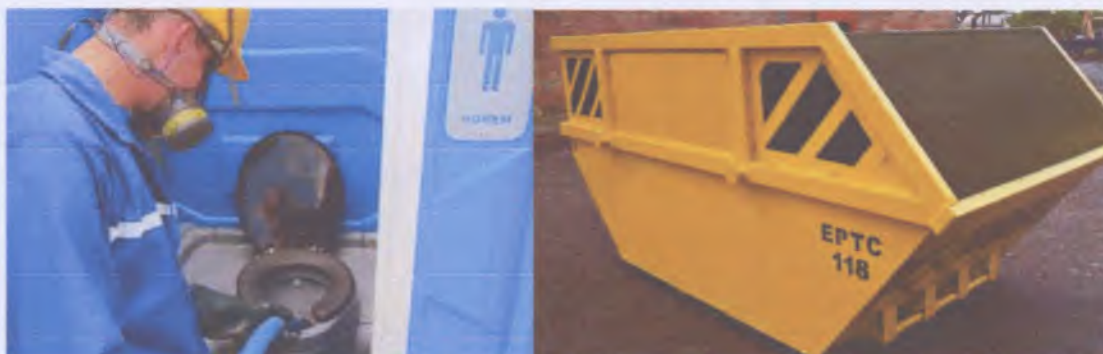
Figura 1 – Banheiro químico, incluindo limpeza diária e caixa coletora de entulho
